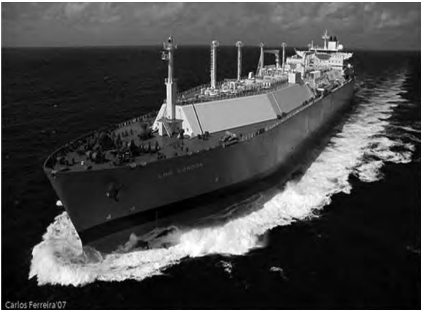
Figure 6-18 Membrane type LNG tanker
